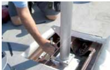
2 Setzen der Stütze
