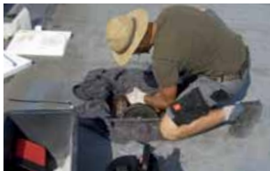
1 Apertura della copertura del tetto
