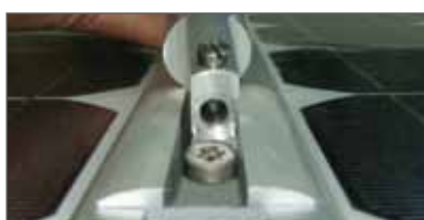
Nástroj dolním vyfrézováním nasadit na šroub.
