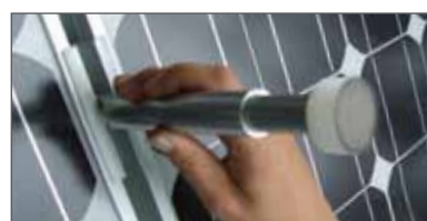
Kuličku umělohmotným kladivem zarazit. Hlava tlukadla je z hliníku a není vhodná pro práci s kovovým kladivem.
