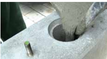
Colare la malta per iniezione nelle fondazioni
