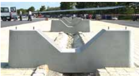
Fondazione prefabbricata inserita e livellata
