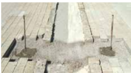
Pali di iniezione installati prontamente
