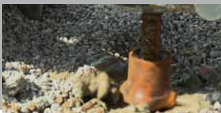
Fuoriuscita di malta di cemento dalla punta di perforazione a croce
